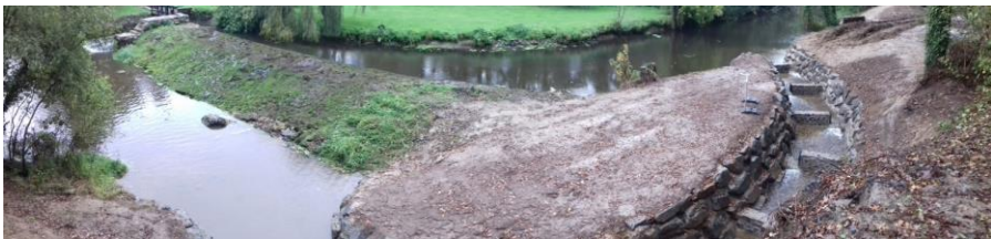
Ouvrage aménagé en 2019 au Moulin du Cirque
